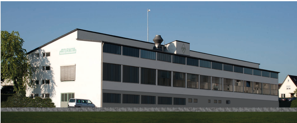
Verwaltungsgebäude Office building
